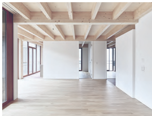
In Querrichtung liegt alle 66 Zentimeter ein Deckenbalken auf den Primärträgern.
